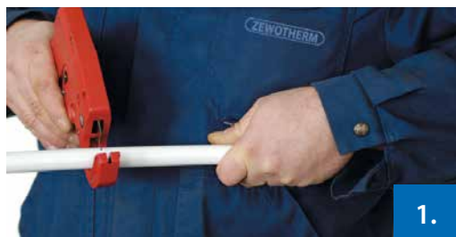
Abbildung 1: Ablängen des Rohres
