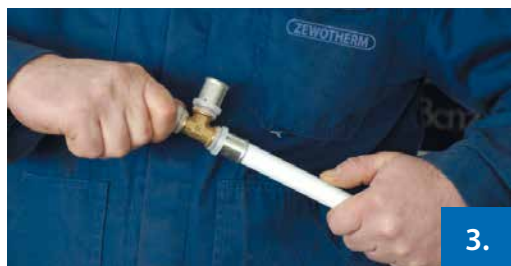
Abbildung 3: Einsetzen des Fittings
