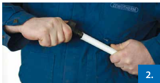
Abbildung 2: Kalibrierung und Entgraten des Rohres
