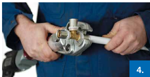
Abbildung 4: Verpressung / Beenden des Pressvorgangs
