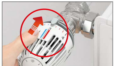
Abb. 11: Sparclip nach vorn schieben
