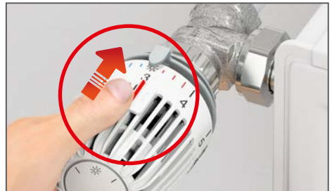
Abb. 9: Sparclip nach vorn schieben
