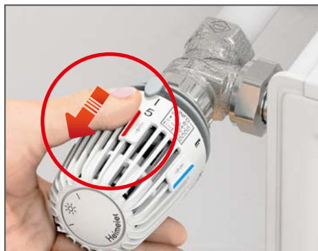
Abb. 1: Sparclip zurück schieben
