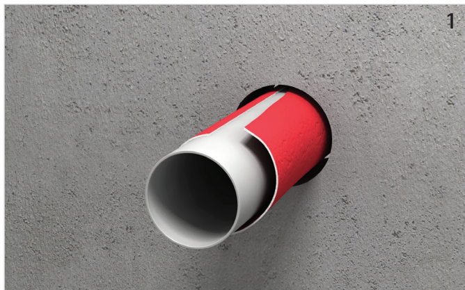
Rohrleitung (ggf. mit Schallschutzschlauch) installieren.
